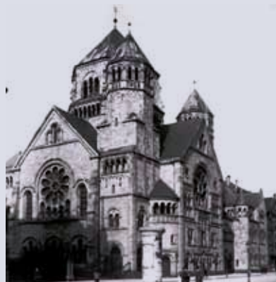
Die Große Synagoge an der Kasernenstraße in Düsseldorf; 1903 erbaut, am 10. November 1938 in Brand gesteckt, am 29. November 1938 abgebrochen
